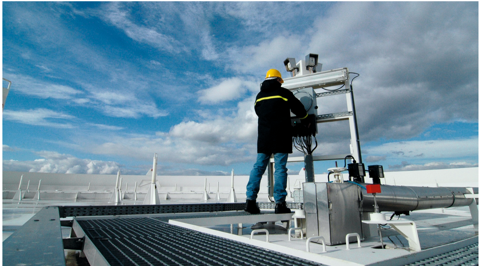
Die überarbeitete F-Gase-Verordnung gilt seit dem 11.03.2024 – mit weitreichenden Auswirkungen für Betreiber von Kälte-, Klima- und Wärmepumpenanlagen. Bild: Stadnik auf Pixabay
